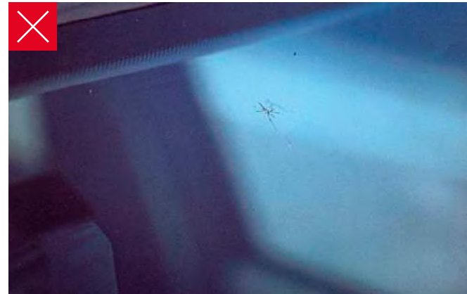
Absplitterung mit Anzeichen von Rissbildung
